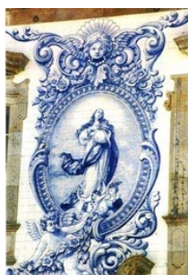
Fachada da Igreja de Santa Maria (Covilhã)
